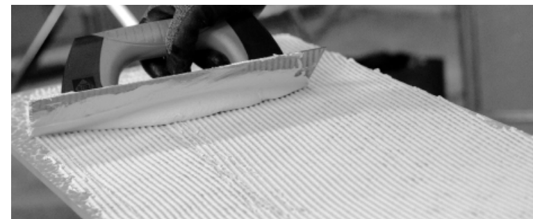
Make sure the thickness of the layer of adhesive cement is uniform | Asegúrate de que el grosor de la capa de cola sea uniforme | Veiller à ce que l'épaisseur de la couche de colle soit uniforme | Vergewissern Sie sich, dass die Kleberschicht gleichmäßig ist
