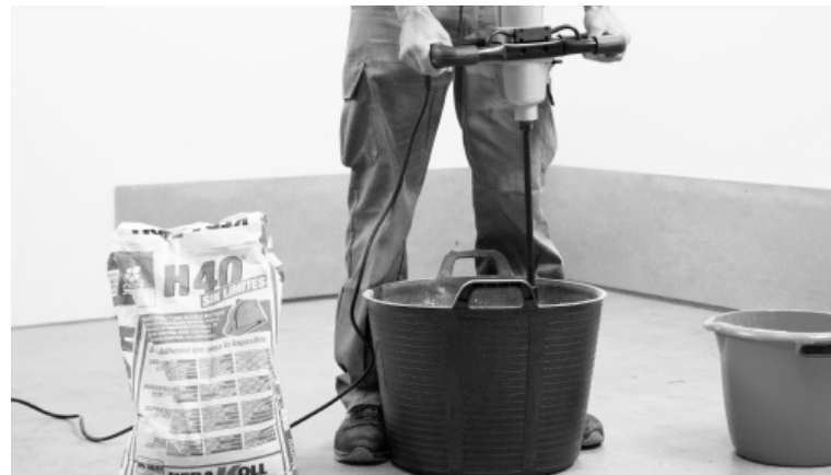
Prepare the adhesive cement | Prepara el cemento de agarre | Préparer le ciment à prise rapide Bereiten Sie den Klebemörtel vor
